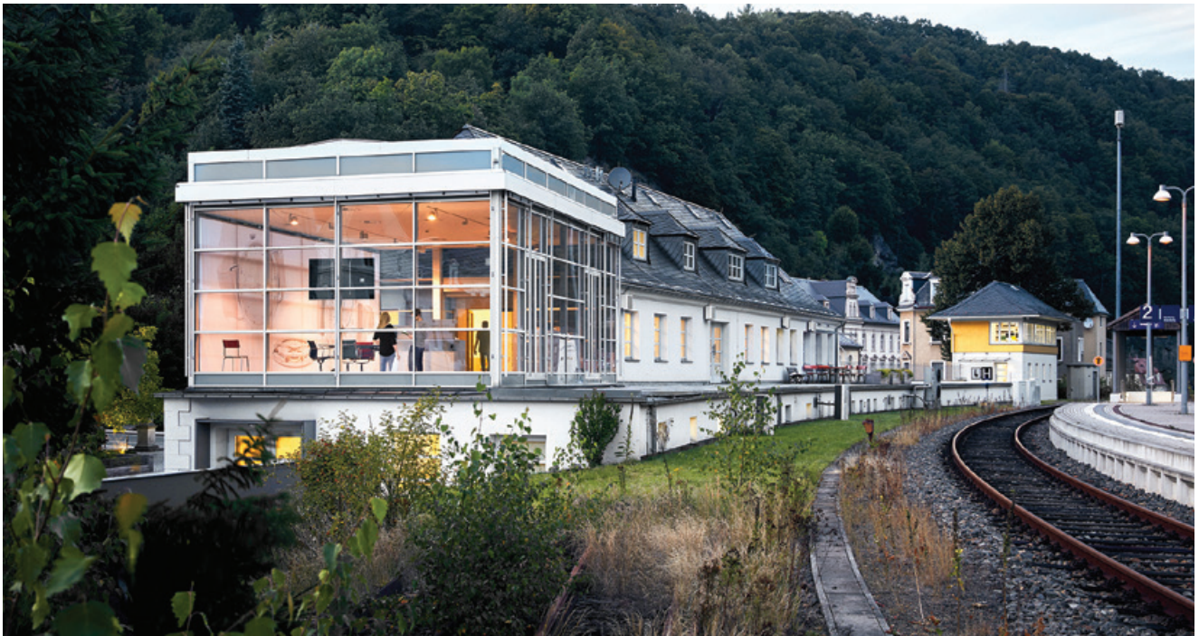
La sede nella vecchia stazione ferroviaria di Glashütte: si tratta di circa 1.500 metri quadrati.
